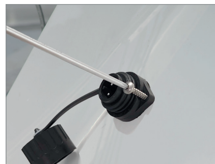
[bild 15] Skruva fast kontakten med två träskruvar
