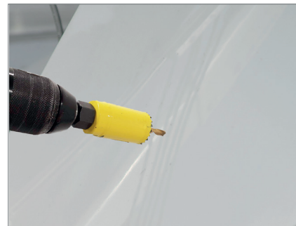
[bild 13] Borra ett 22 mm hål för kabelgenomföringen
