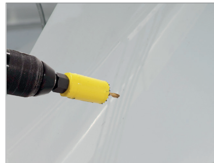
[Kuva 13] Pora 22mm reikä kaapelien läpivientiä varten
