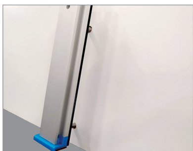
[kuva 9] Sovita kiskossa olevat pultit reikiin
